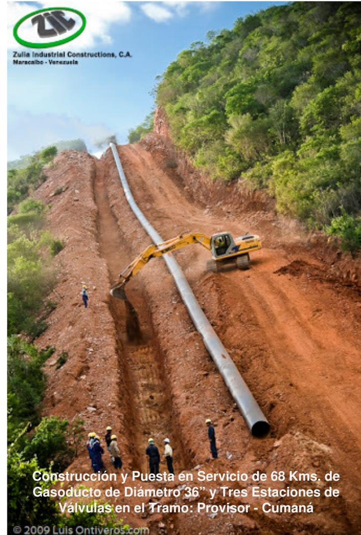
Construcción y Puesta en Servicio de 68 Kms. de Gasoducto de Diámetro 36" y Tres Estaciones de Válvulas en el Tramo: Provisor - Cumaná
